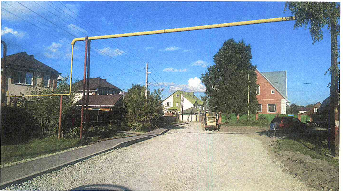
Устройство основания из фракционированного щебня
