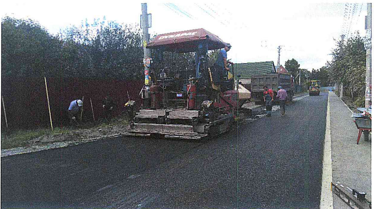
Устройство покрытия из а/б смеси тип Б марка II
