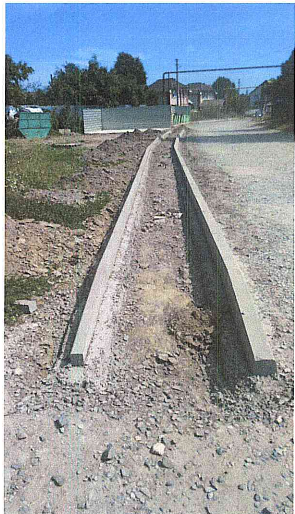
Установка бортового камня
