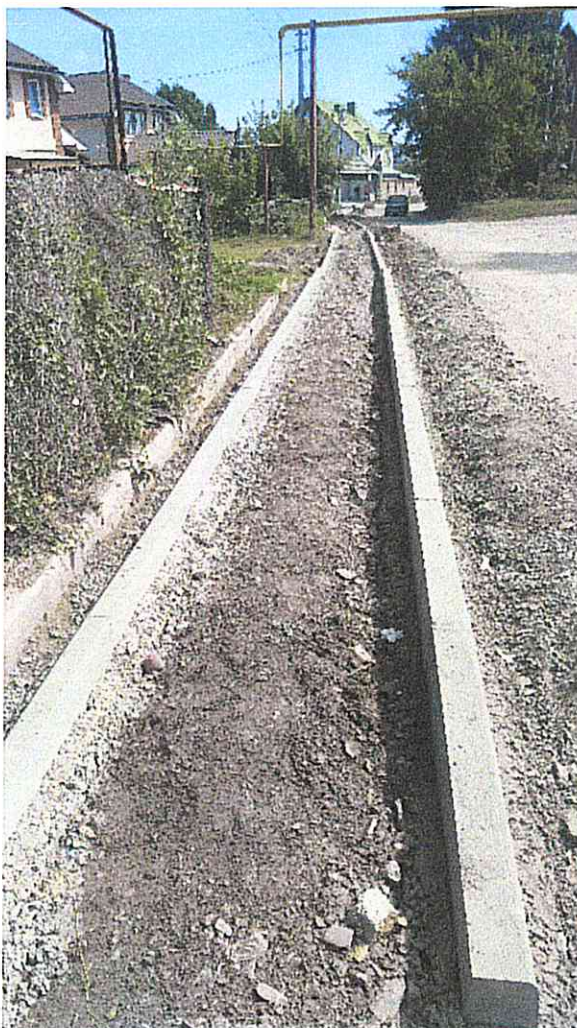
Установка бортового камня
