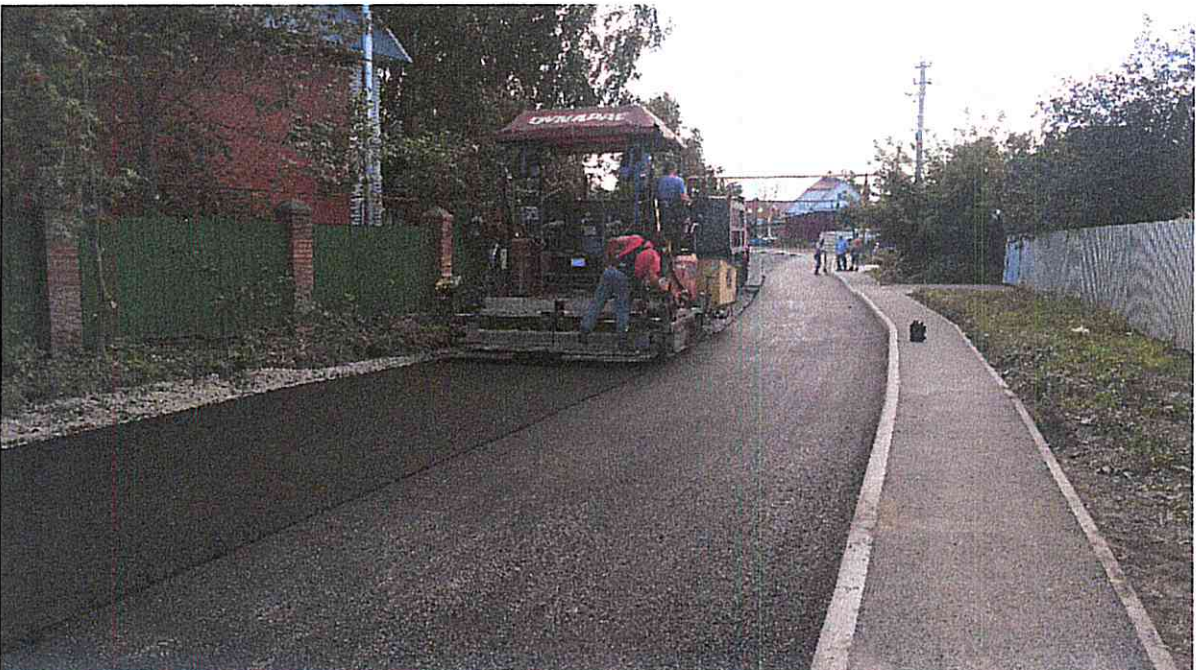
Устройство покрытия из а/б смеси тип Б марка П
