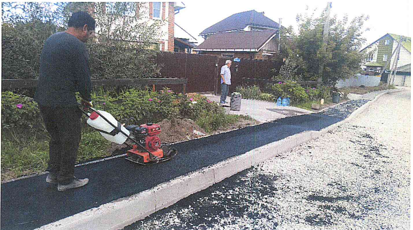
Устройство покрытия тротуаров из а/б смеси тип Г
