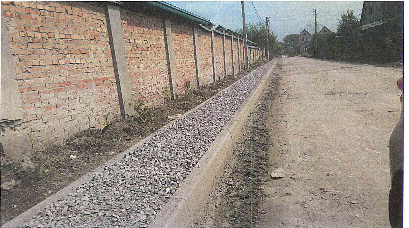
Устройство основания тротуаров
